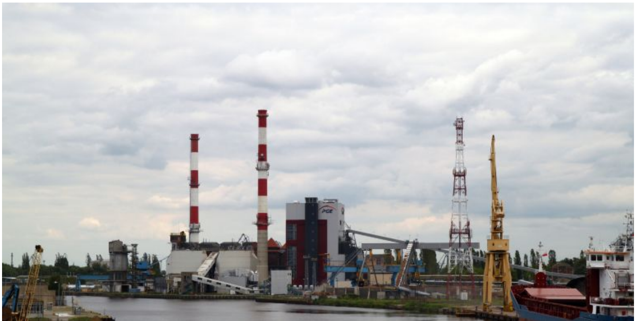
Elektrownie Pomorzany i Szczecin są jednym z podstawowych źródeł ciepła dla miasta Szczecina.
